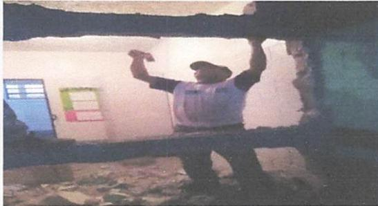
**Foto1: DEMOLICION DE PARED DE LA COCINA**
