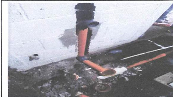
Foto 1: COLOCACIÓN DE DRENAJE EN SANITARIOS
