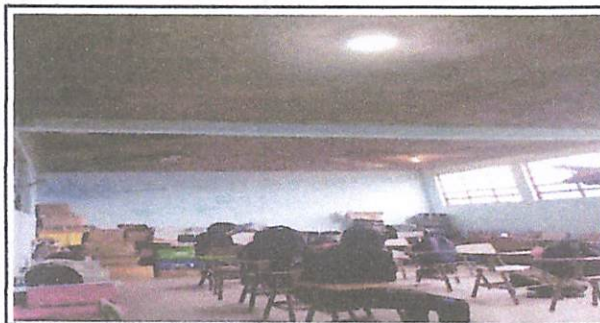
Foto 5: REPARACION DE SALON DE CLASES
