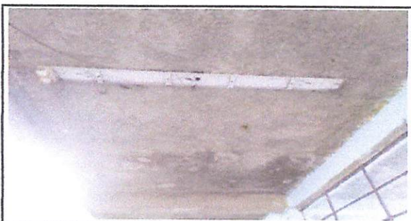
Foto 6: REPARACIÓN DE ENERGIA ELÉCTRICA, LABORATORIO DE COMPUTACION.
