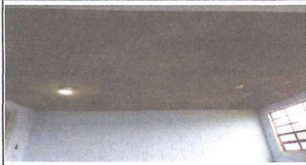
Foto 3: REPARACION SALON DE CLASES
