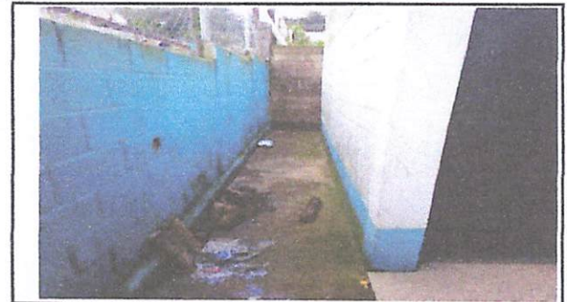
Foto 2 PINTADA PARED PERIMETRAL
