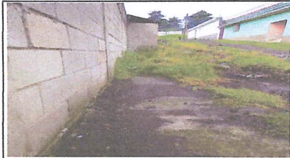
Foto 2 AMPLIACION COCINA, DEMOLER PARED Y HACER TERRAZA
