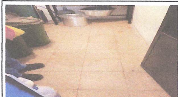
Foto 4 COLOCACION DE PISO CERAMICO
