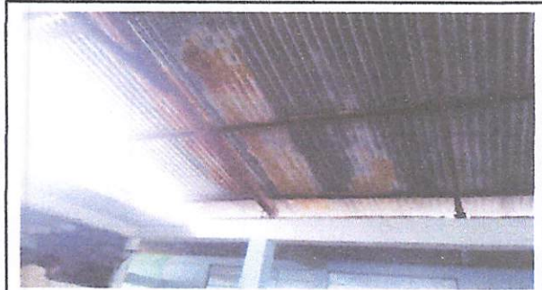
Foto 3: CAMBIO DE TECHADO DEL SALÓN
