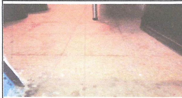
Foto 3: CAMBIO DE PISO
