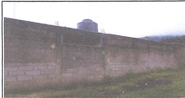
Foto 1: AMPLIACIÓN Y MEJORAMIENTO DE COCINA HACER PARED
