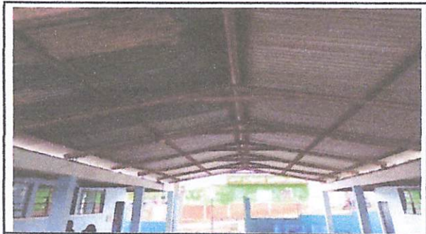
Foto 2: CAMBIO DE LAMINAS
