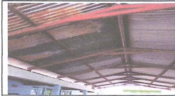
Foto 1: DESMANTELAR LAMINAS
