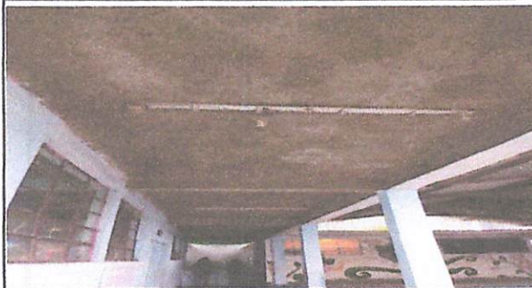
Foto 1: REPARACION ENERGIA ELECTRICA CORREDOR
