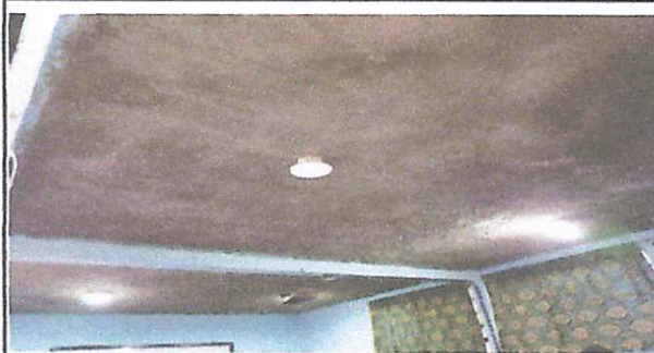
Foto 4 REPARACION DE SALON DE CLASES
