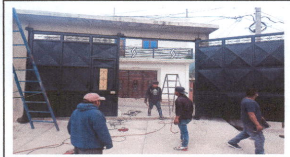
Foto 1: Cambio de porton.
