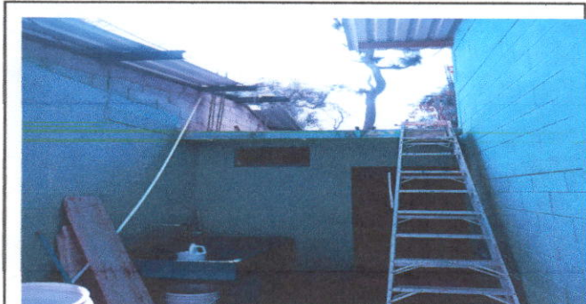
Foto 4: Construcción de depósito.
