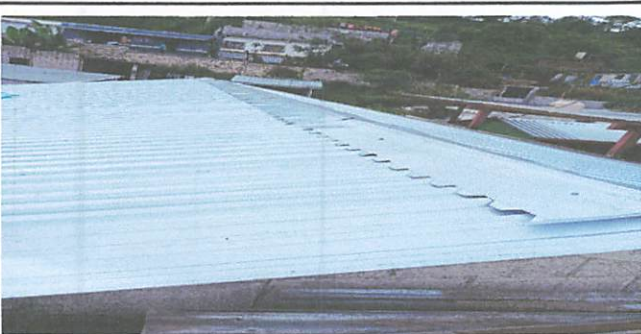
Foto 5: CAMBIO DE LAMINA TERMINADO
