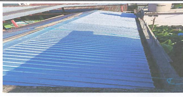
Foto 6: CAMBIO DE LAMINA TERMINADO
