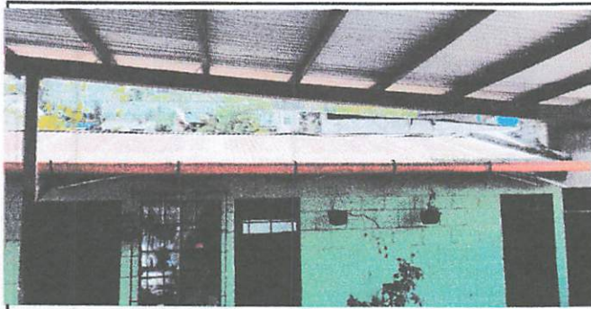
Foto 1: Techo del area de la cocina y los baños
