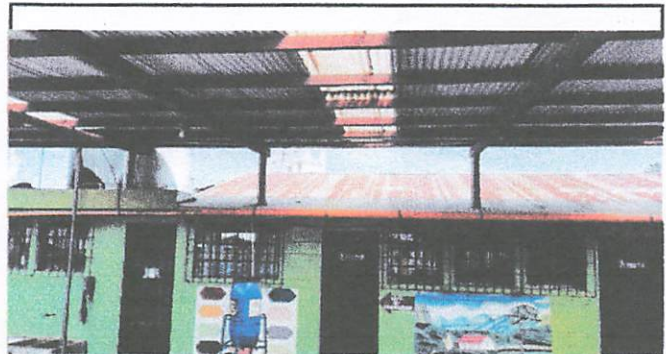
Foto 2: Techo del area de las aulas
