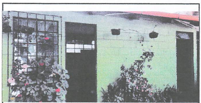
Foto 6: area delos sanitarios actualmente.
