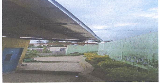
foto 8: colocación de canales
