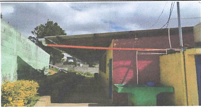
foto 9: colocacion de bajadas de agua pluvial
