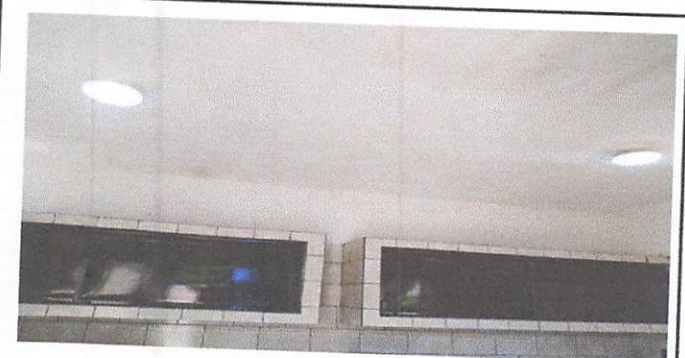
Foto 3: instalación eléctrica dentro de la cocina, cableado y colocación de accesorios
