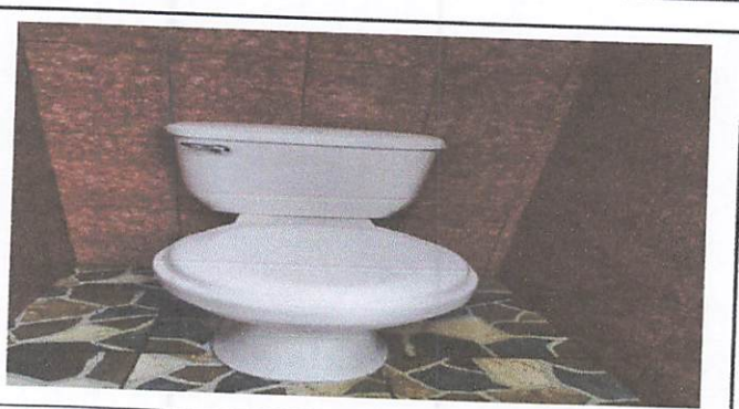
Foto 5: cambio de 4 sanitarios y 3 tapaderas deterioradas
