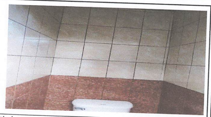
Foto 4: cambio de sanitario para maestros y colocación de azulejo
