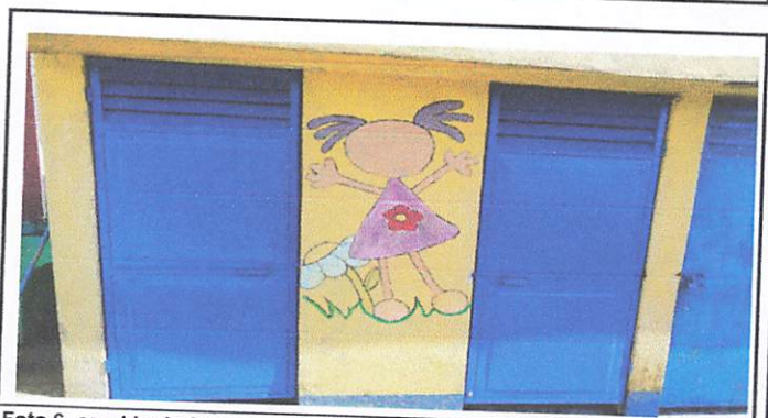
Foto 6. cambio de 2 puertas de madera
