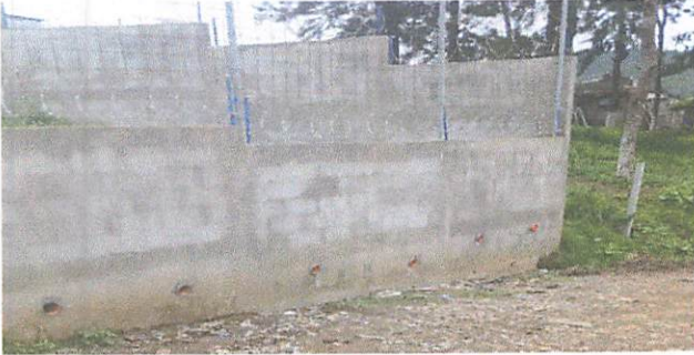
foto 11: colocación de respiraderos en muro perimetral
