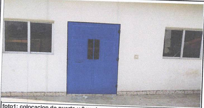
Foto 1: colocacion de puerta y 2 ventanas a la cocina
