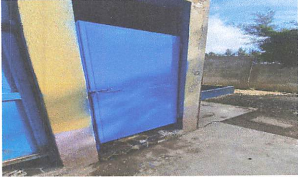
foto 7: cambio de puerta de metal de sanitario
