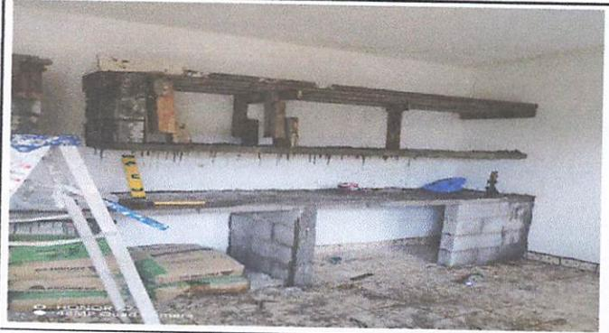
Foto 2: colocación de gabinete y aéreo para colocar trastes de cocina, aéreo de cemento con puertas de metal pintadas color madera
