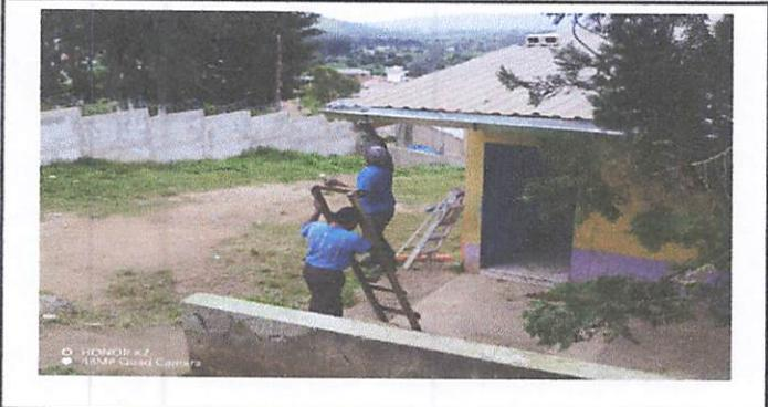
**foto 9: colocacion de bajadas de agua pluvial**
