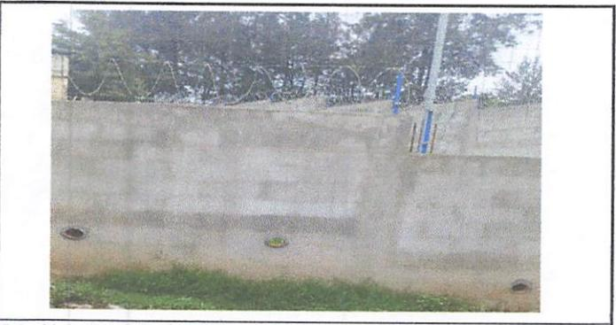
**foto 11: colocación de respiraderos en muro perimetral**
