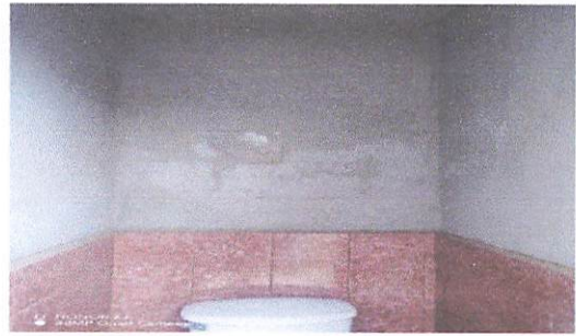
Foto 4: cambio de sanitario para maestros y colocación de azulejo
