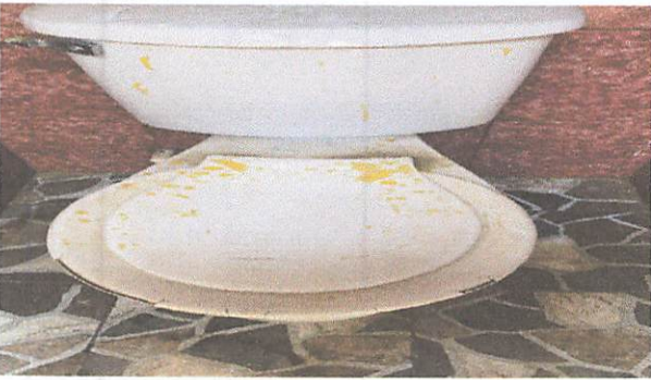
Foto 5: cambio de 4 sanitarios y 3 tapaderas deterioradas
