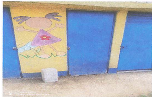
Foto 6. cambio de 2 puertas de madera
