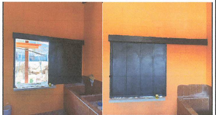
Foto 4: PUERTA CORREDIZA INSTALDA
