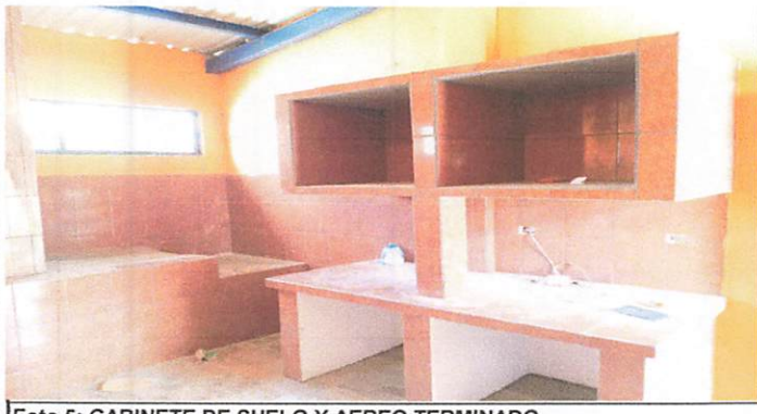
Foto 5: GABINETE DE SUELO Y AEREO TERMINADO.
