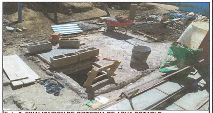
Foto 6: FINALIZACION DE CISTERNA DE AGUA POTABLE
