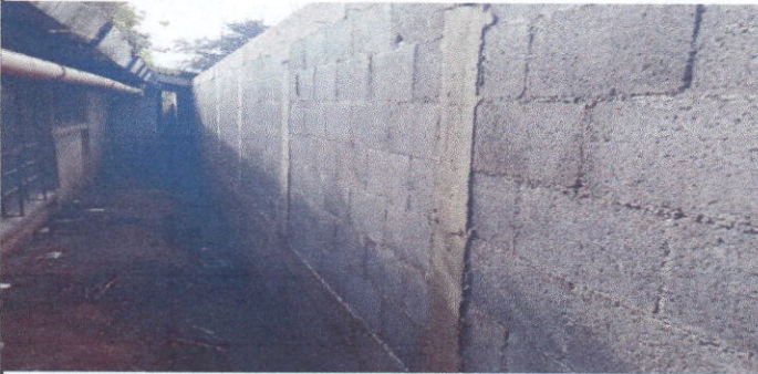
FOTO DESPUES CONTRUCCION DE MURO PERIMETRAL
