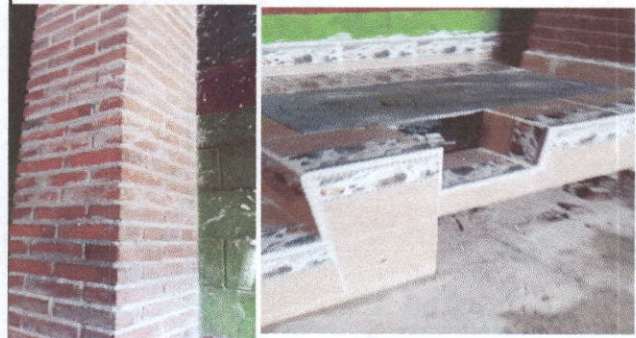
DESPUES contruccion de pollo rural con plancha de tres hornillas con chimenea
