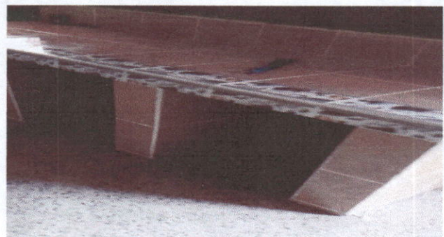
foto DESPUES CONTRUCCION DE TOP DE COCINA CON ACABADO DE AZULEJO
