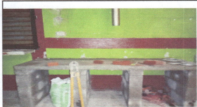
foto DURANTE A CONTRUCCION DE TOP DE COCINA
