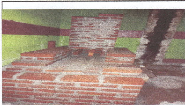
DURANTE contruccion de pollo rural con plancha de tres hornillas
