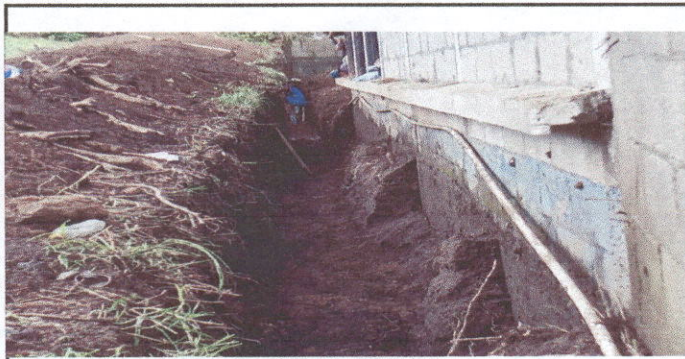
FOTO DURANTE A CONTRUCCION DE MURO PERIMETRAL
