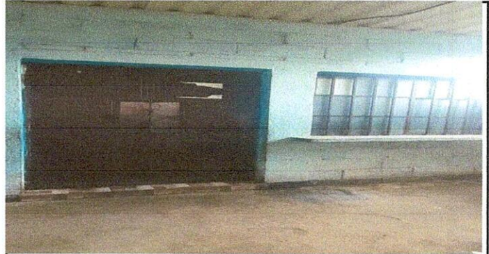
Foto 2: MANTENIMIENTO DE PUERTA Y VENTANAS DE LA COCINA
