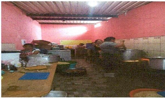
Foto 3: ELABORACION DE UN TOP Y COLOCACIÓN DE AZULEJO EN COCINA
