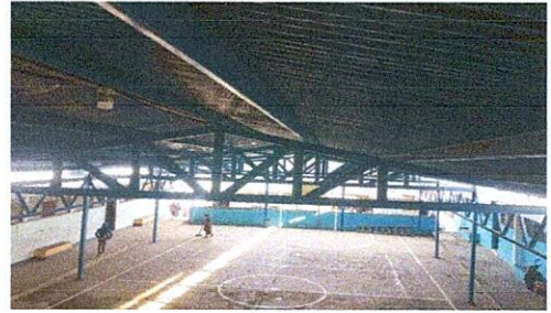
FOTO 2 BAJADAS DE AGUA
