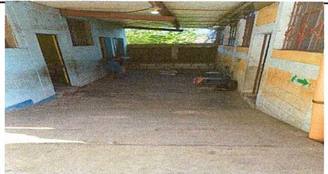
Foto 6: LEVANTADO DE MURO FRENTE A COCINA
