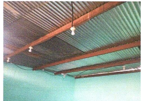
FOTO 4 INSTALACION DE FOCOS
