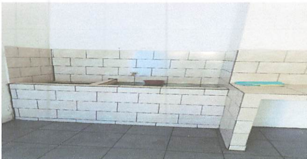
Foto 3: Construcción de pila en cocina forrada de azulejo
