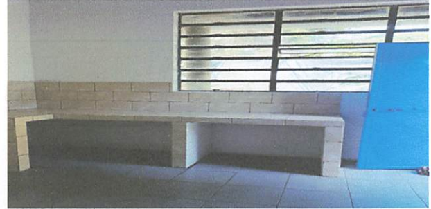
Foto 4: Repellar, Colocación de Azulejo y demolición de plancha de cocina
