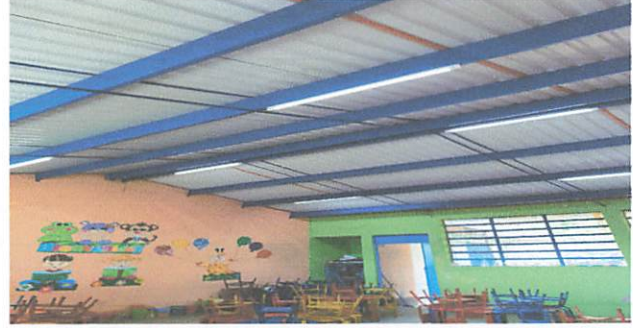
Foto 2: Cambio de instalación Eléctrica Aulas, Corredor, Dirección y Cocina
