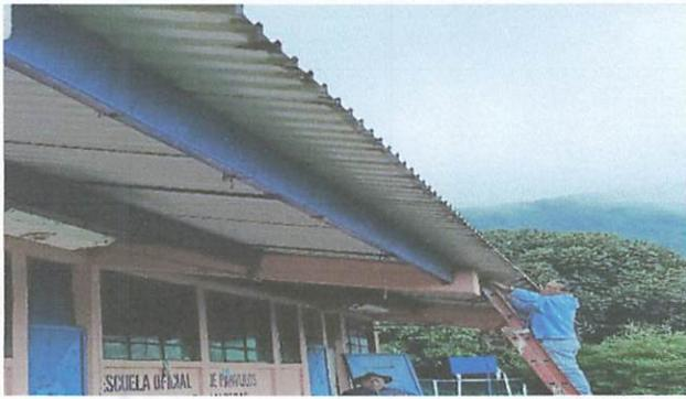
Foto1: Colocación de canales y bajadas de agua
