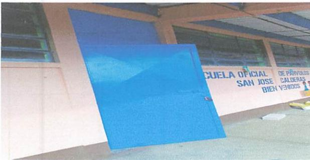
Foto 5: Colocación de bisagras, chapas y pintado de las puertas de aulas cocina y dirección
