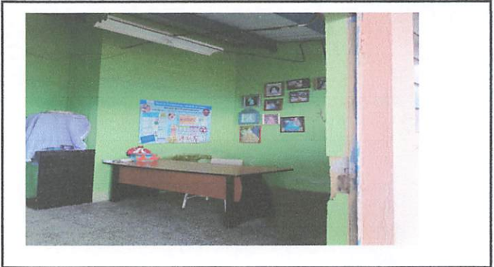
Foto 2: Repello, Colocación de piso en dirección
