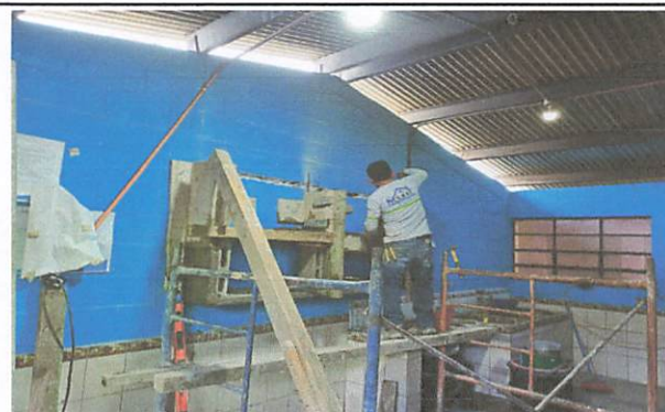
Foto 4: Construcción de un gabinete en la cocina.
