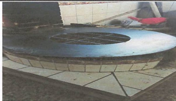
Foto 6: Colocación de una comal en la cocina.
