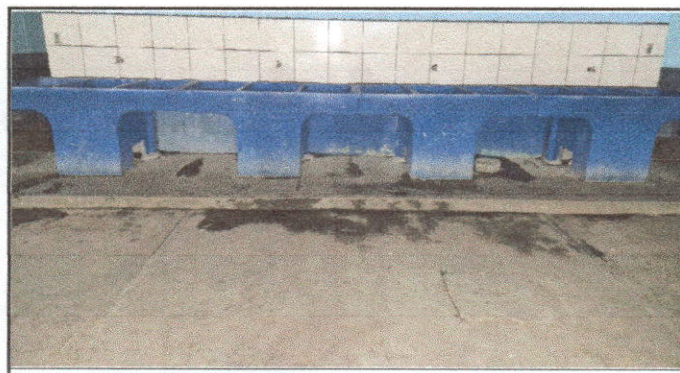
Foto 5: MANTENIMIENTO DE DRENAJES, CAMBIO DE PILAS, Y AZUJEJIADO
