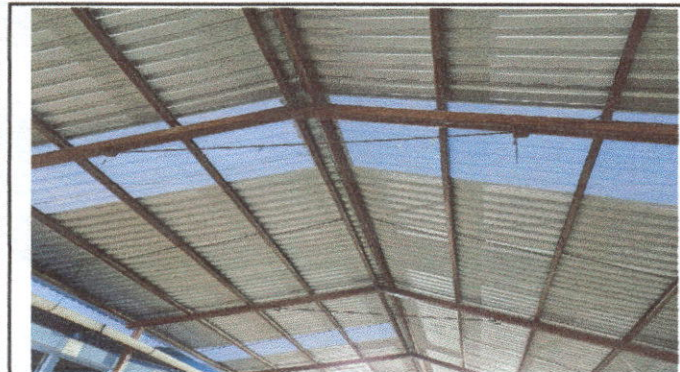
Foto 3: SUSTITUCION Y COLOCACION DE LAMINAS POR LAMILUZ
