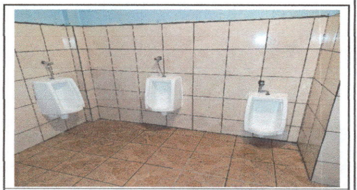
Foto 6: SUSTITUCION DE MIGITORIOS Y AZUJEJIADO
