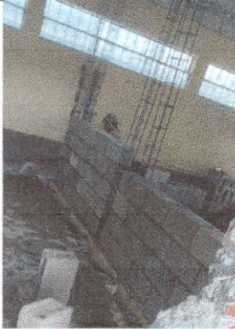
Foto 1: LEVANTADO DE PARED PARA HABILITAR ESPACIO DE COCINA, CON POLLO ARTESANAL, PILA, PISO CERAMICO, AZULEJO.
