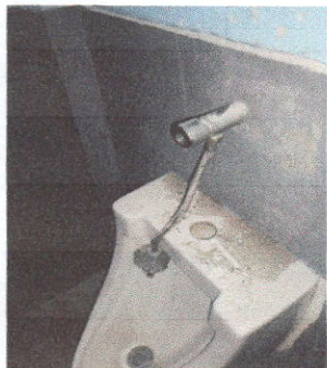
Foto 1: SUSTITUCION DE MIGITORIOS
