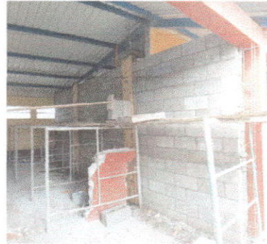
Foto 2: CIERRE DE CORREDOR Y CONSTRUCCIÓN DE PUERTA DE COCINA
