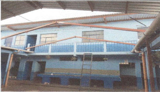
Foto 3: TERMINACION DE TECHADO DE PATIO
