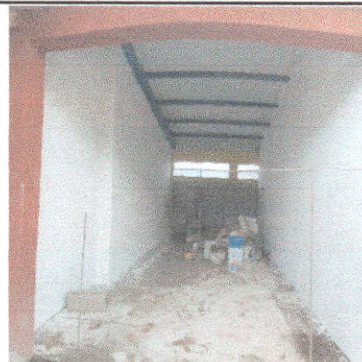
Foto 4: REPELLO DE TODAS LAS PAREDES DE ESPACIO DE COCINA
