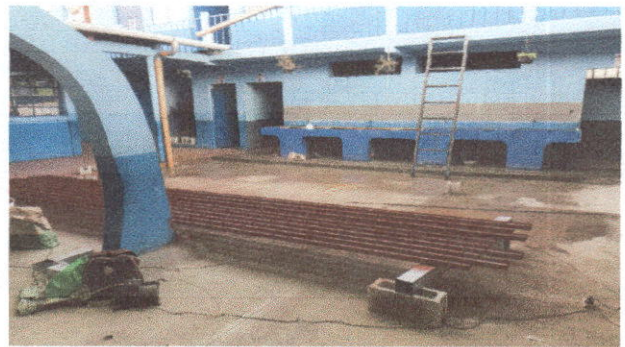
Foto 4: ESTRUCTURA METALICA SIGUIENDO EL MISMO PATRON DE ESTRUCTURA
