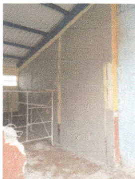
Foto 3: REZANADO DE PARED DE ESPACIO DE COCINA
