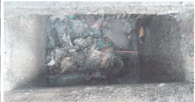
Foto 6: MANTENIMIENTO DE DRENAJES
