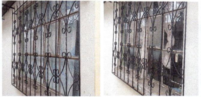
FOTO 4. Finalización de mantenimiento de balcones con pintura de aceite de la parte trasera de módulo primaria y puesta de vidrios rotos
