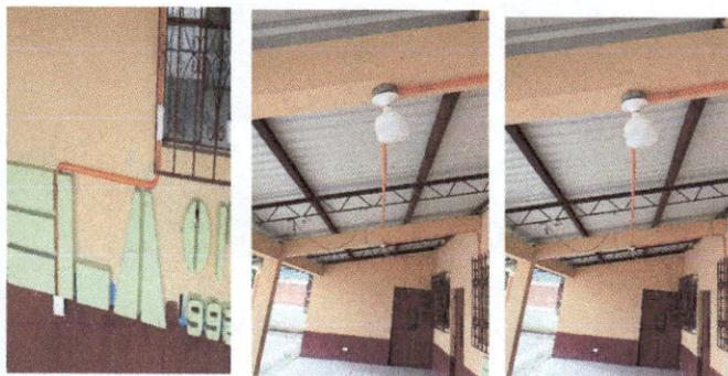
FOTO 5. Finalización de intalación y mejoramiento de energía eléctrica de pasillos y puesta de toma corrientes en diferentes áreas.
