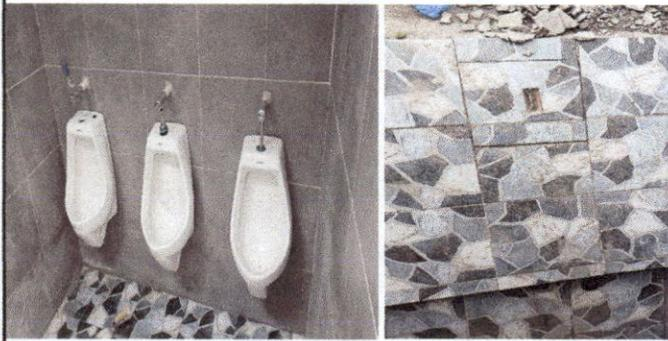
FOTO 3. Finalización de colocación de Mingitorios en area de baño de varones así como hecha de nuevo drenaje y colocación de azulejo y piso antideslizante.
