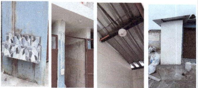
FOTO 6. Finalización de muro de protección a lavamanos e instalación de energía electrica en interior de baños y azulejeado a lavamanos
