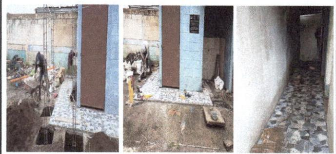
FOTO 6. Proceso de construcción de muro de protección a lavamanos, colocación de piso cerámico antideslizante parte delantera y trasera de baños y cambio de pila
