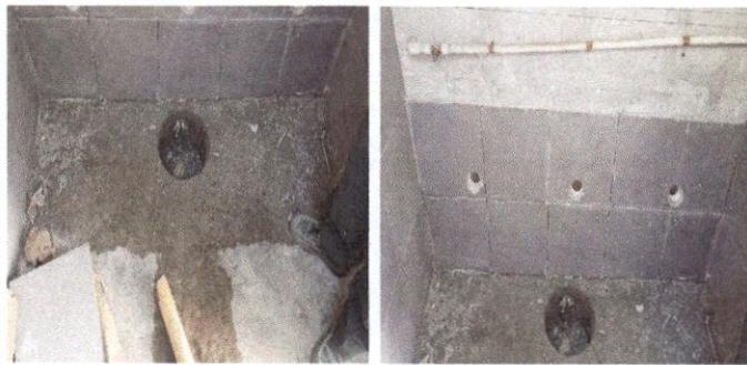
FOTO 3. Proceso de elaboración de nuevo drenaje en area de baños de varones, cambio de pileta a mingitorios colocación de azulejo y piso antideslizante.
