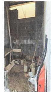
Instalación de puerta de cocina
