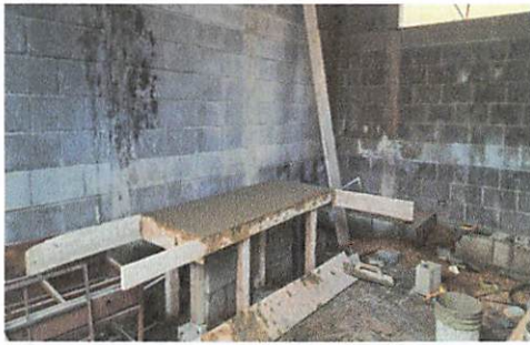
Colocación de piso en el aula de tercero y quinto
