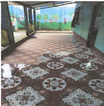
Colocación de piso en corredor de la escuela
