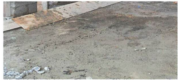
Colocación de piso en bodega.
