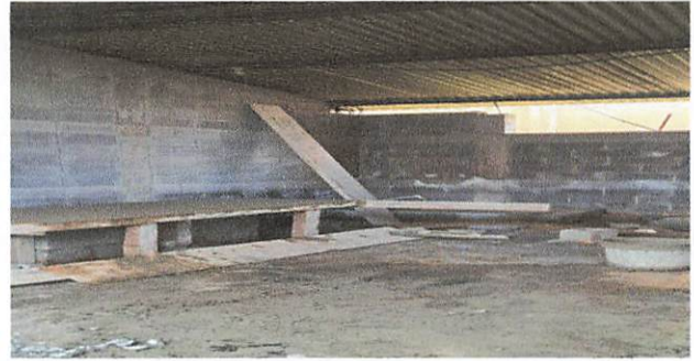
Colocación de techo en cocina
