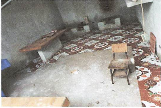
Colocación de piso en cocina
