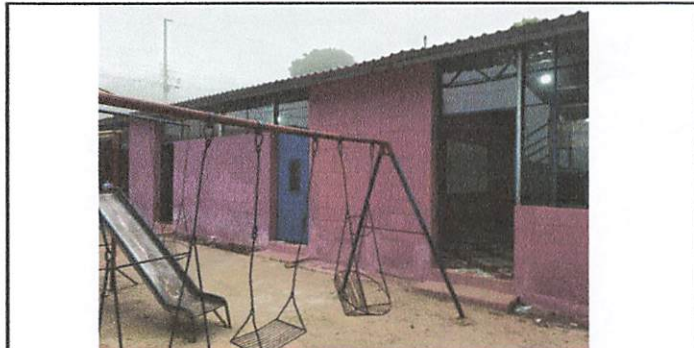
Pintura exterior de las aulas
