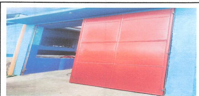
Foto 5: Reglon 3 Instalación de portón.
