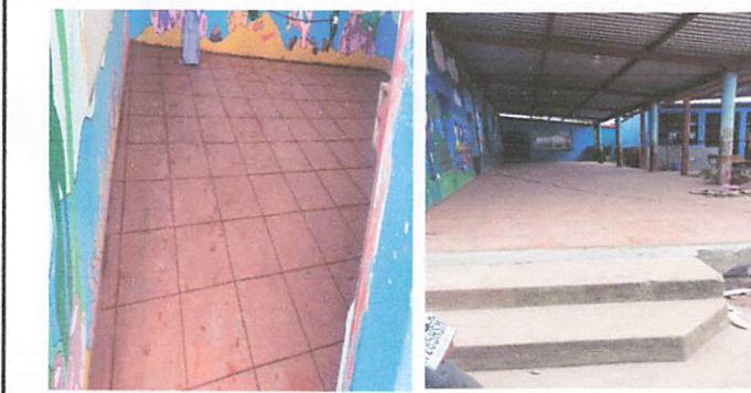
Foto1: Renglon1 piso antideslizante
