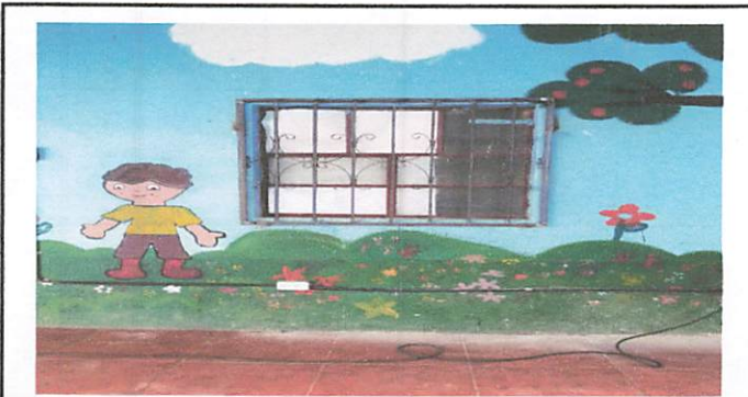
Foto 3: Reglon 2 Balcones de aulas.
