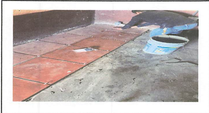
Foto1: Renglon1 piso antideslizante
