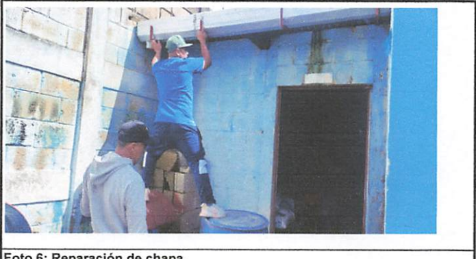
Foto 6: Reparación de chapa.
