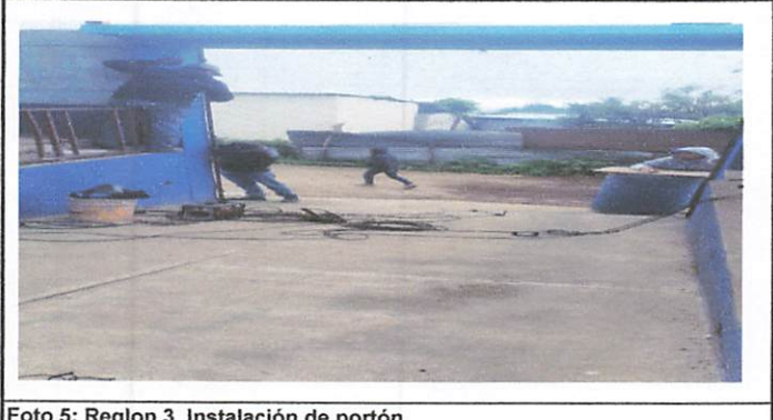
Foto 5: Reglon 3 Instalación de portón.
