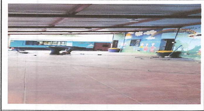
Foto 3: Reglon 2 Balcones de aulas.
