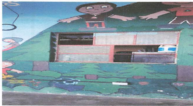
Foto 3: Reglon 2 Balcones de aulas.
