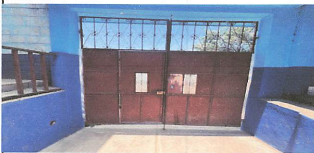
Foto 5: Reglon 3 Instalación de portón.
