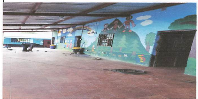
Foto 4: balcones de cocina.
