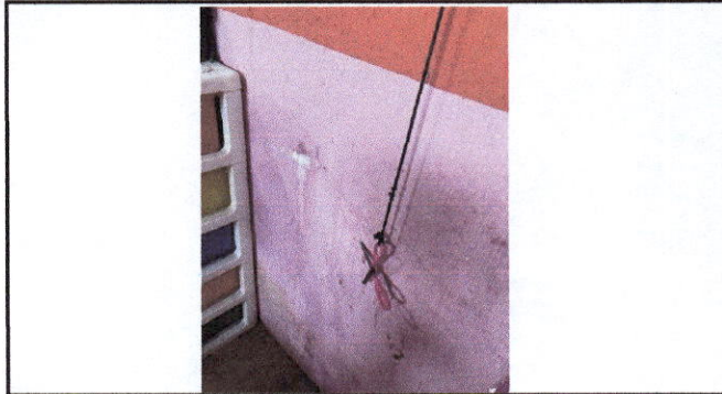
pintura de socalo de interior de las aulas del lado derecho de la escuela
