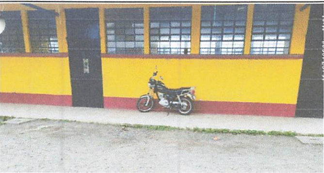
Foto 5: repacion de puertas y pintura
