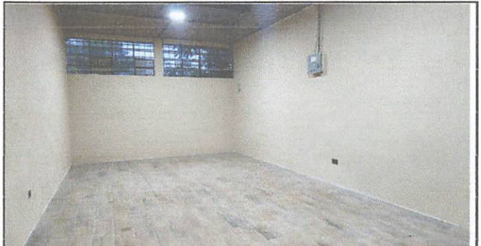
Foto 6: repello y cernido de paredes area de dirección.
