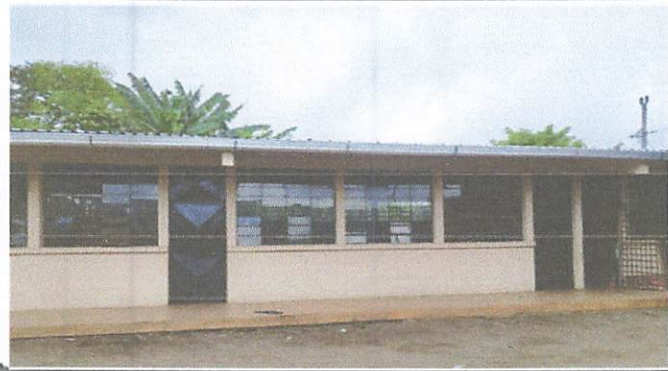
Foto 1: cambio de techo por derriero
