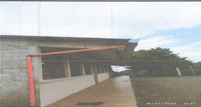
Foto 3: Colocacion de canales y agua pluvial
