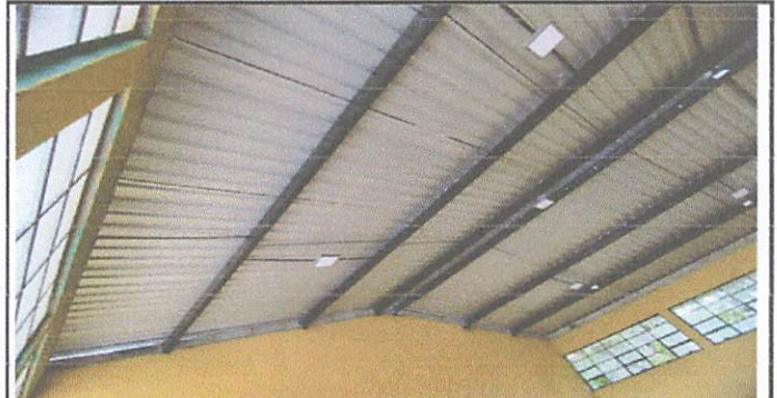
Foto 4: cableado e instalación eléctrica
