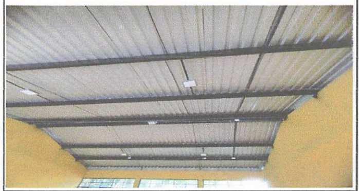
Foto 2: Remozamiento de costaneras
