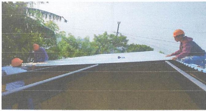
Foto 1: cambio de techo por derloro
