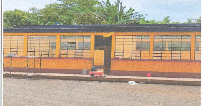
Foto 2: Remozamiento de costaneras
