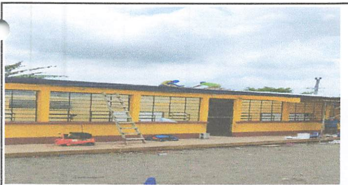
Foto 5: repacion de puertas y pintura
