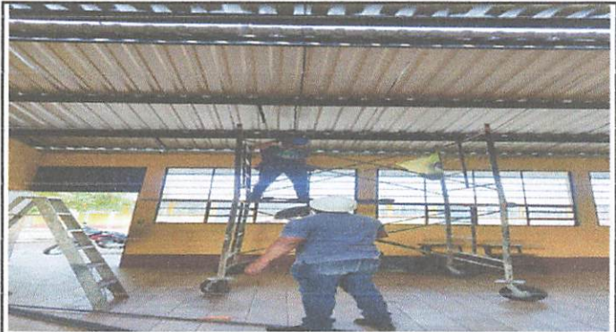
Foto 4: cableado e instalación eléctrica
