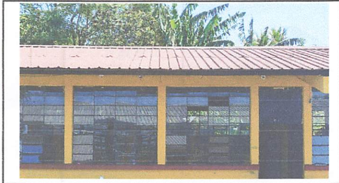
Foto 3: colocacion de canales y bajadas de agua pluvial.
