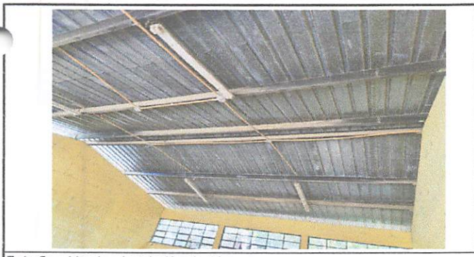
Foto 5: cableado e instalación eléctrica.
