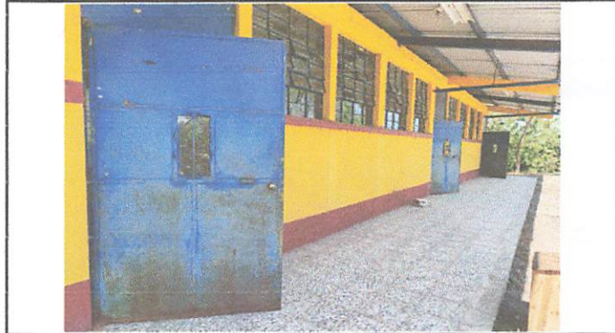
Foto 4: reparación de puertas y pintura.
