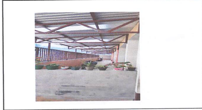
Foto 4: estructura y techado del pasillo
