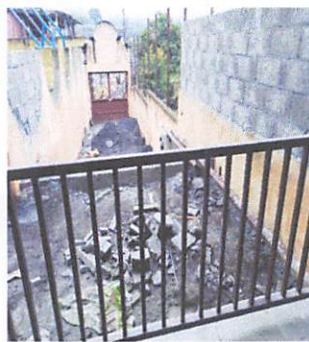
Foto 3: de la entrada donde se hizo gradas y rampa
