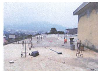
Foto 2: de la loza ante de la ejecución
