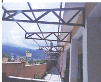
Foto 4: estructura y techado del pasillo
