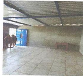
Foto 8: Cambio de lamina en mal estado por lamina Troquelada Aluzinc Terminado
