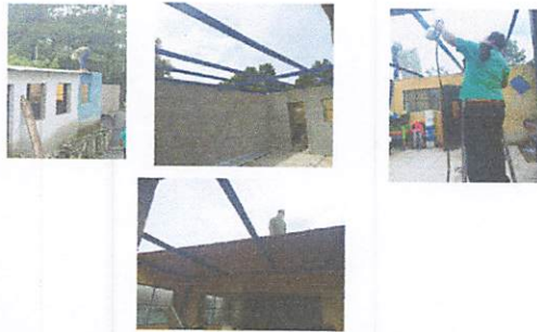
Foto 9: sustitucion de lamina por lamina troquelada Aluzinc
