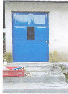
Foto 8: colocación de puerta nueva por necesidad del del salon y su seguridad
