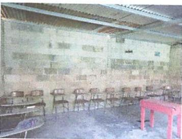
Foto 9: sustitucion de lamina por lamina troquelada Aluzinc
