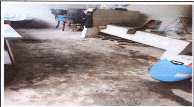
Foto 2: parte interna de la cocina terminar polletón y parrilla
