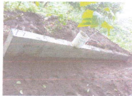
Foto 4: MURO DE CONTENCIÓN
