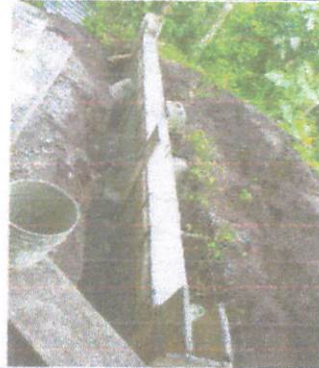
Foto 4: MURO DE CONTENCIÓN
