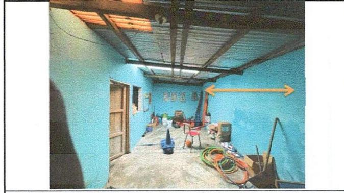
foto 2: Remodelación de cocina, eliminación de muro lateral derecho y agrandado de cocina
