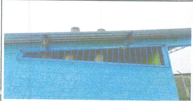
Foto 1: Reparación o sustitución de área de cocina: balcón de metal
