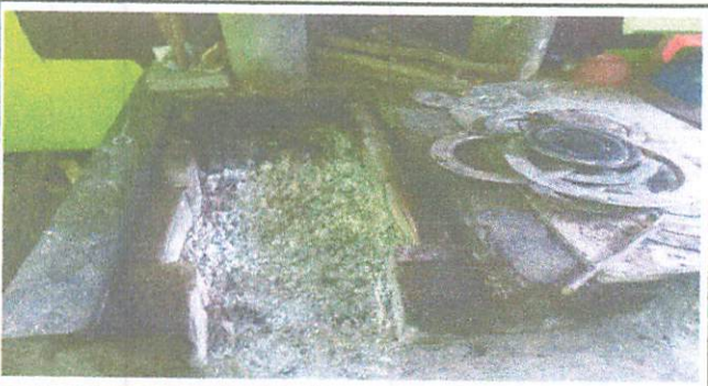
Foto 3: Reparación o sustitución de área de cocina: sustitución de dos planchas.
