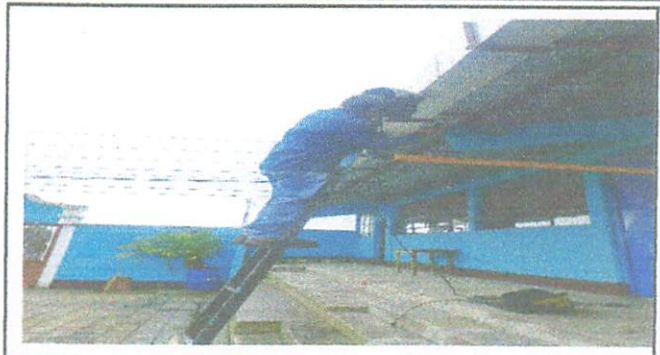
Foto 2: Canales y bajadas de agua, bajada de tubos de 4 pulgadas.
