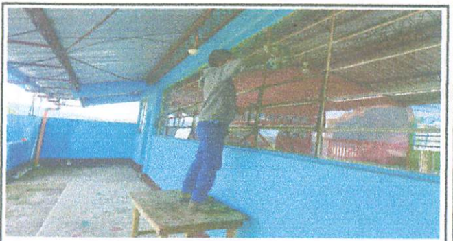
Foto 4: Ventanas: reparación de ventanas de salones de clases.
