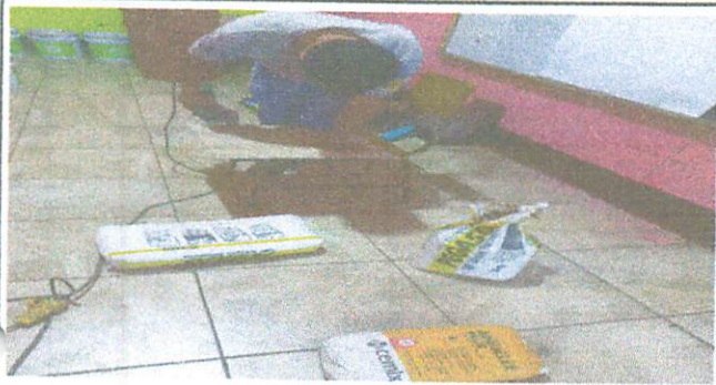
Foto 7: piso: sustitución de piso liso por piso cerámico antideslizante
