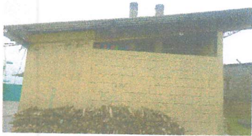
Foto 1: Reparación o sustitución de área de cocina: balcón de metal
