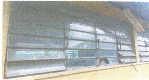
Foto 4: Ventanas: reparación de ventanas de salones de clases.
