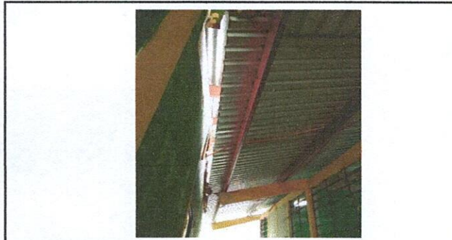
foto 3 canal para recepcionar agua pluvial
