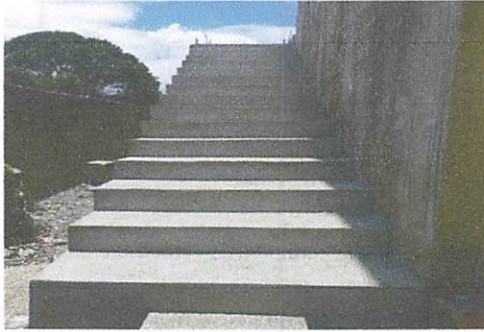
Foto 1: Construcción de gradas
