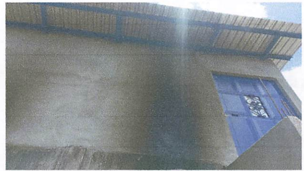
Foto 4: colocación de puertas
