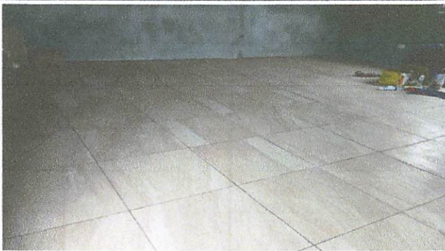
Foto 3: Finalización de la colocación del piso
