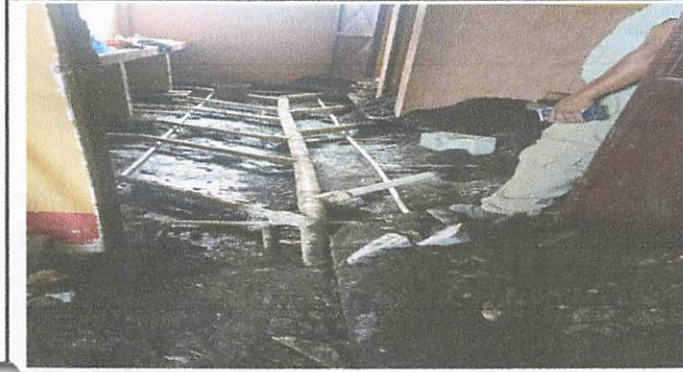
Foto 1: Cambio de tubería de drenaje de los baños
