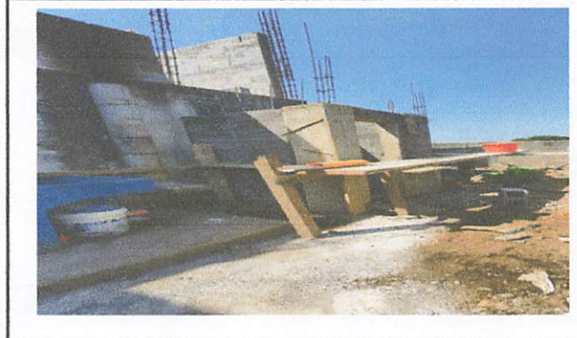
Foto 2: construcción parte de fila cocina
