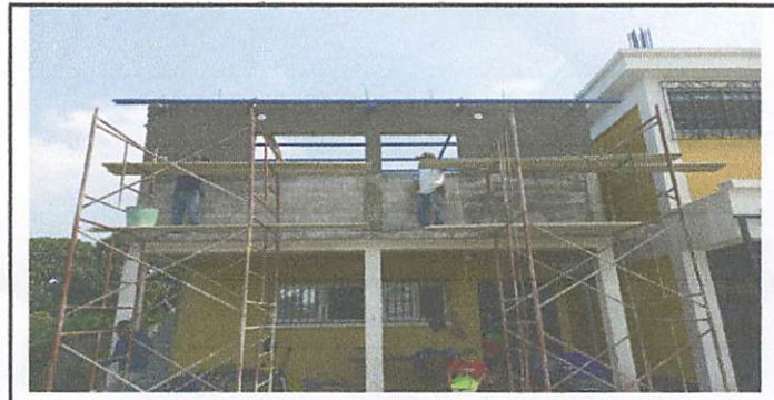
Foto 6: construcción de la cocina
