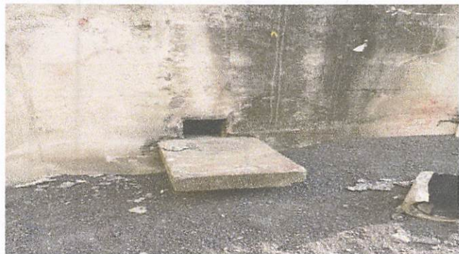
Foto 1: noestaban las pilas
