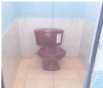
Foto 5 sustitución de sanitarios de china y accesorios
