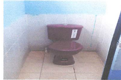
Foto 4 Sustitución de sanitarios de china y accesorios
