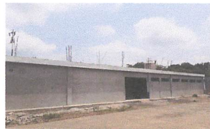
Foto 6 Reparación de repello y cernido en paredes
