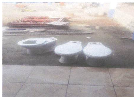
Foto 4 Sustitución de sanitarios de china y accesorios
