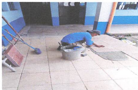
Foto 1 Sustitución de piso dañado por piso ceramico antideslizante
