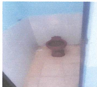
Foto 6 Sustitución de sanitarios de china y accesorios
