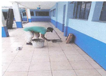
Foto 2 Sustitución de piso dañado por piso antideslizante
