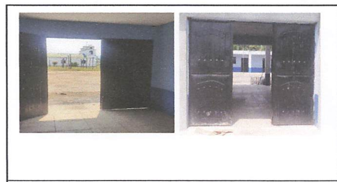
Foto 5 Reparación de portón principal y hechura de contrapuerta principal
