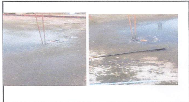
Foto 2 Mantenimiento de bajadas de agua
