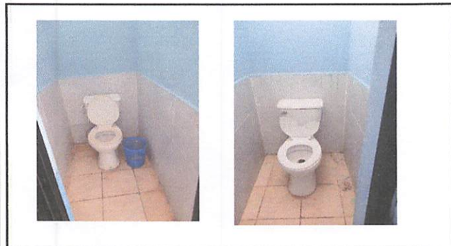
Foto 3 Sustitución de sanitarios de china y accesorios
