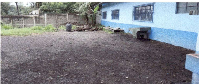
Foto 11: Pavimentación en la parte de atrás de la escuela.
