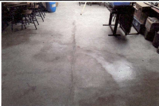
Foto 5: Cambio de piso de la bodega.
