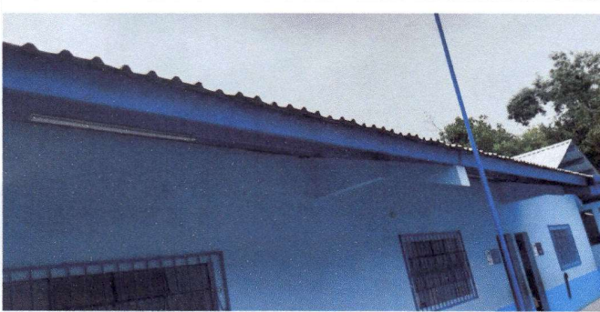
Foto 9: Canales para bajadas de agua.
