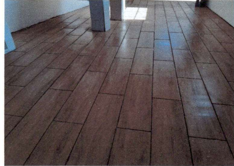
Foto 2: Cambio de piso de la cocina.
