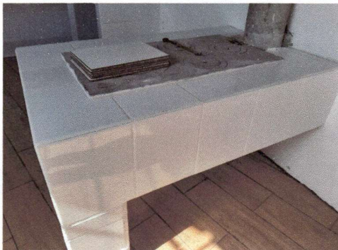
Foto 3: Reparación de la chimenea y plancha de la cocina.
