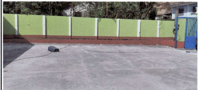
Foto 10: Pavimentación en la parte de en frente adentro de la escuela.
