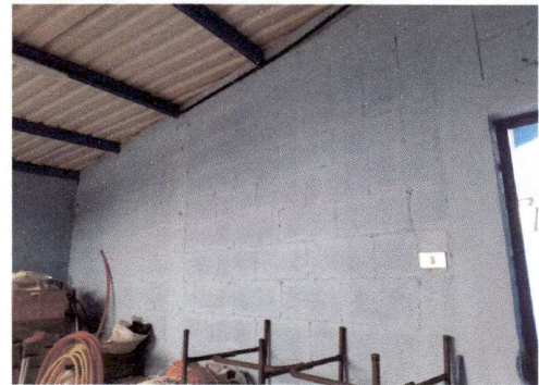
Foto 4: Repello y cernido de las paredes de la bodega.
