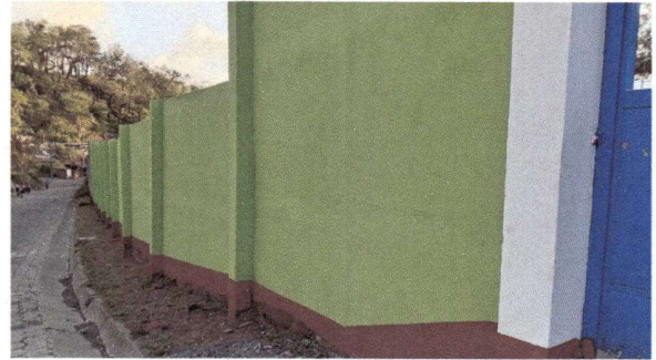
Foto 8: Pintura de la circulación de la escuela parte de afuera.
