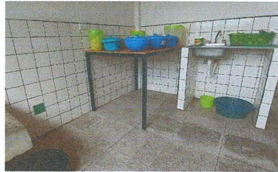
Foto 2: Construcción de mesas de concreto en la cocina de la escuela
