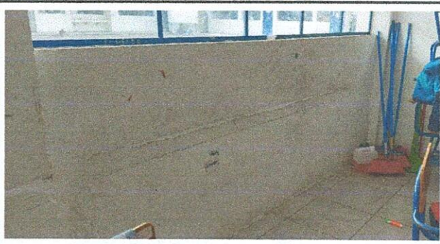
Foto 4: Pintura de paredes interiores: Cambio de pintura de los salones de clases.
